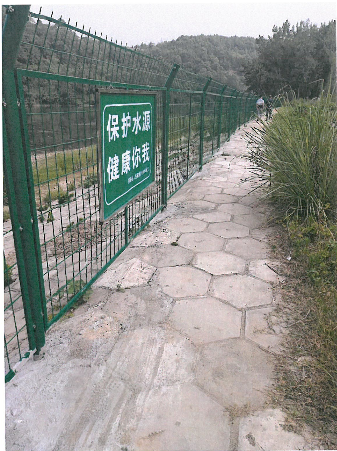
饮用水源一级保护区内隔离防护栏工程已完成
